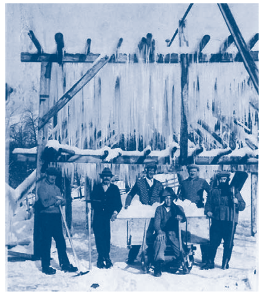
Die „Eisgalgen“ der Bierbrauereien dienten dazu, sich über den Winter hinaus mit Eis einzudecken und damit den Gärraum möglichst lange kühl zu halten. Der Eisgalgen der Brauerei Fulterer stand um 1930 auf der Jakobs-höhe.
